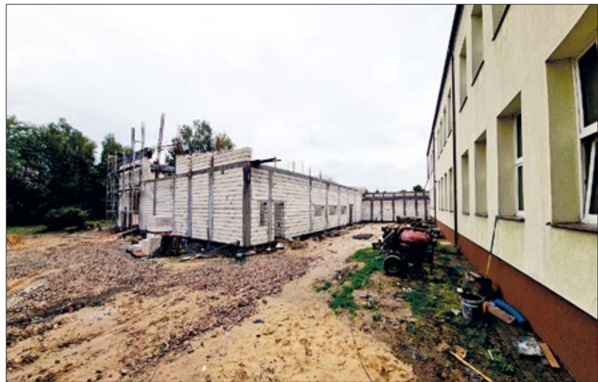
Budowa sali gimnastycznej przy szkole w Ostrowie
